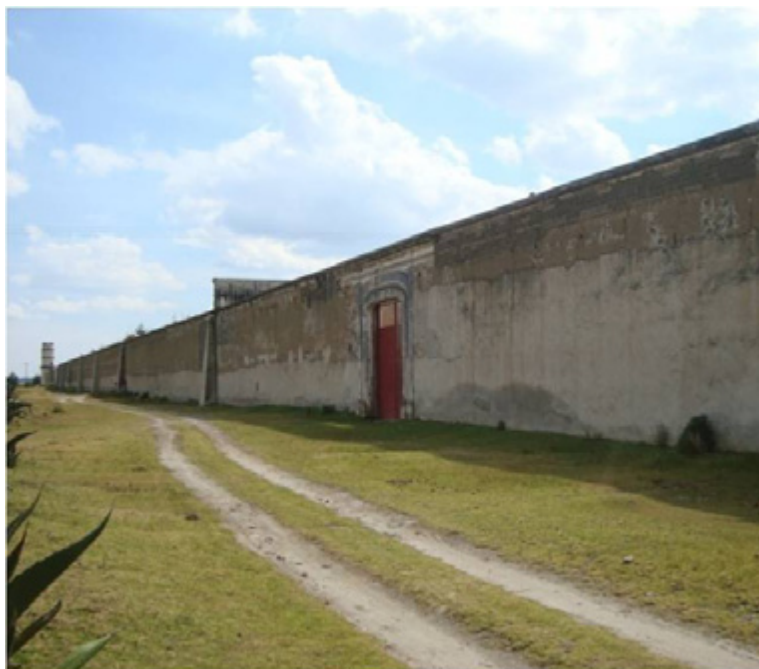
Figura 5. Fachada posterior de la casa grande de la hacienda. Fotografía del autor
