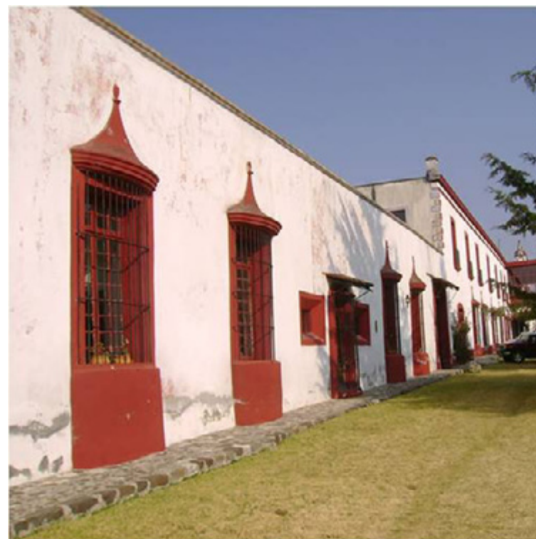
Figura 4. Fachada sur (principal) de la casa grande de Santa Teresa Ixtafiyuca. Fuente: H. Ayuntamiento de Nanacamilpa, 2011
