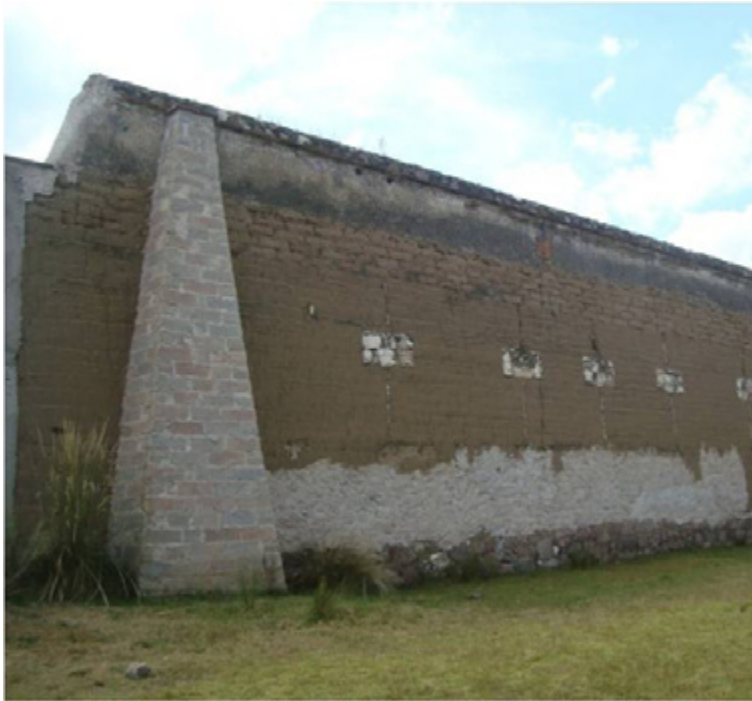
Figura 7. Muro de tapia en la fachada norte de la casa grande. Fotografía del autor
